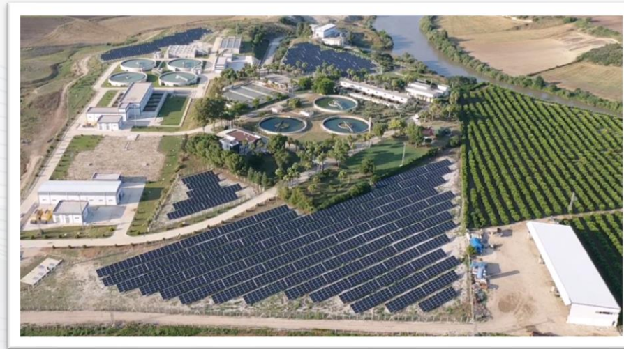
GES (Güneş Enerji Santrali) Projesi
