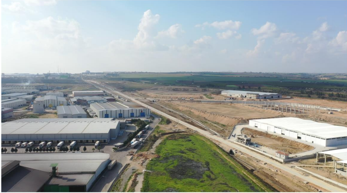
99,35 Hektarlık AOSB 4. İlave Alan Altyapı Projesi
