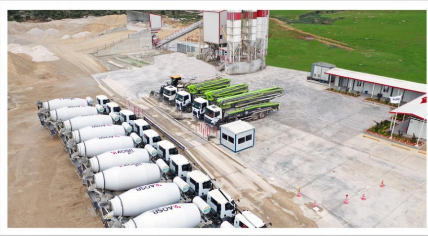
AOSB Hazır Beton Tesisi
